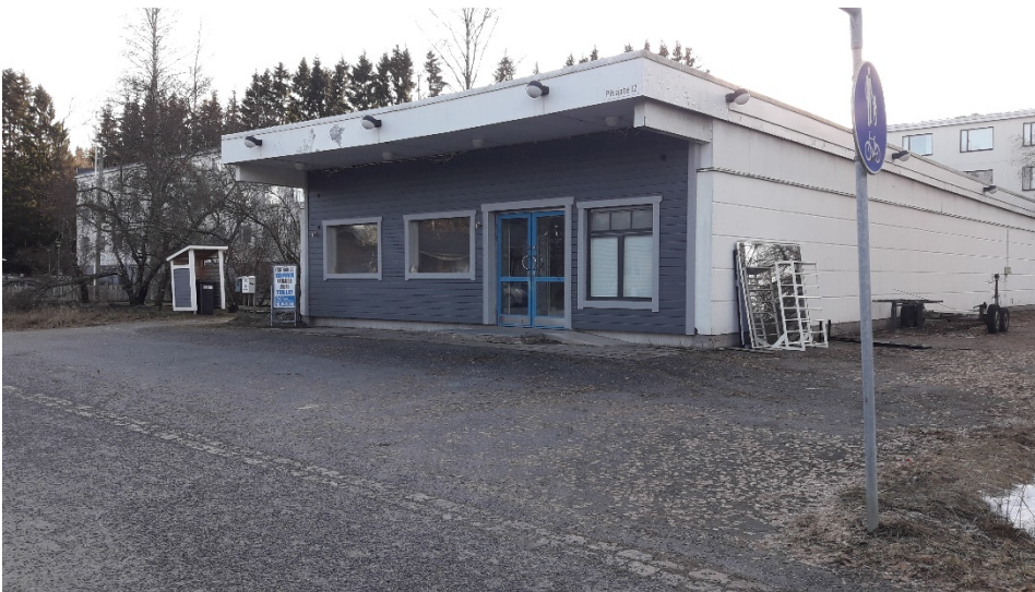
Toimintansa lopettanut liikerakennus. Ympäröivät kerrostalot ovat 4-kerroksisia lamellitaloja. Niiden pääikkunat, parvekkeet ja pihat suuntautuvat uudisrakennuksesta poispäin.
